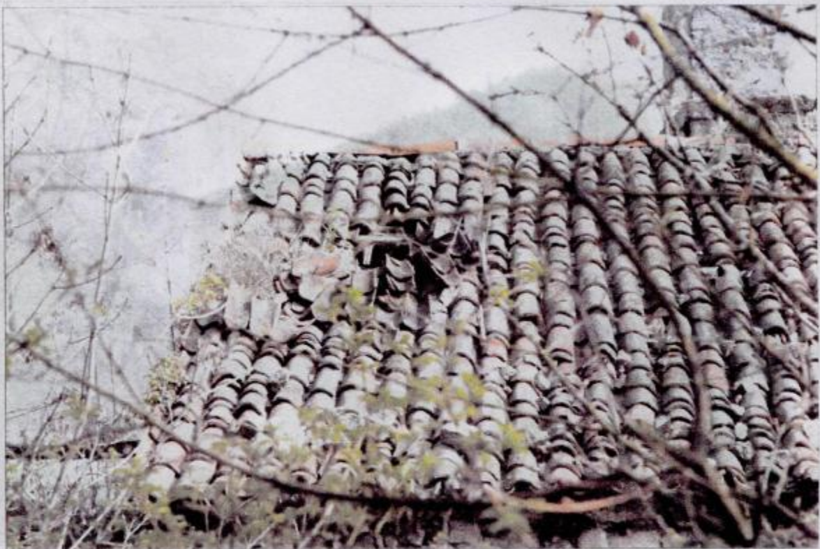
Esterno chiesa - particolare copertura della navata (foto giugno 2010)
