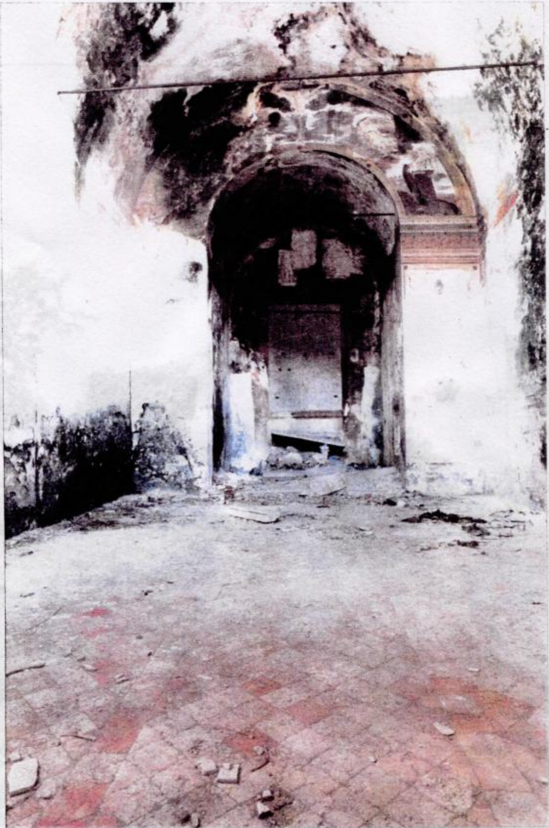
Interno chiesa - parete nord-est (foto ottobre 1991)
