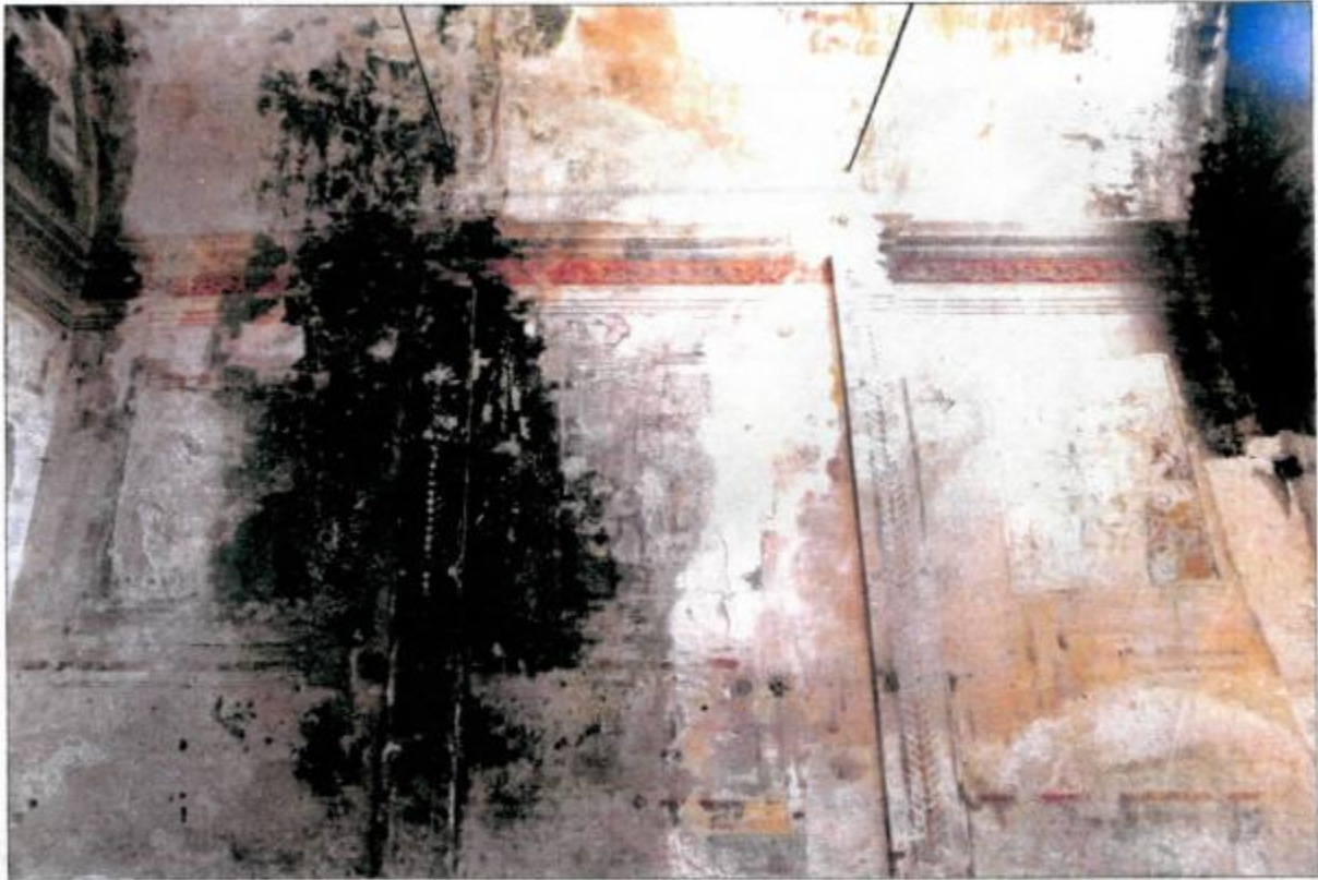
Interno chiesa - parete sud-est (foto ottobre 1991)
