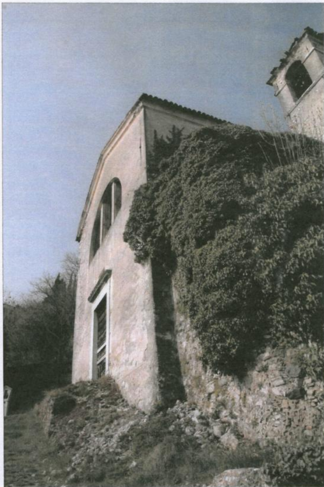
Esterno chiesa - facciata e annesso sud-est (foto marzo 2011)
