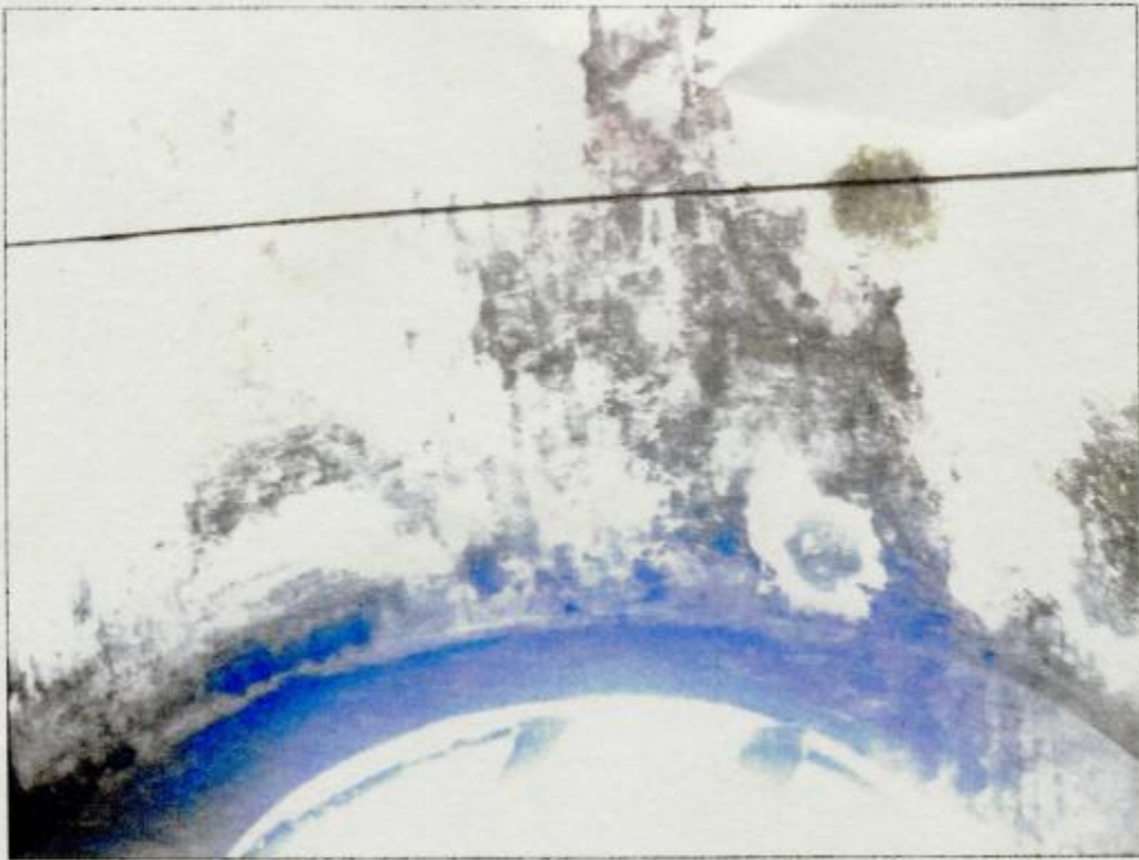
Interno chiesa - volta navata (foto giugno 2010)
